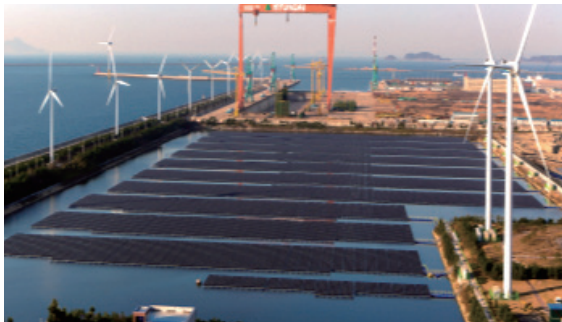
군산 수상태양광발전(2018)새만금 재생에너지 비전 선포의 신호탄
