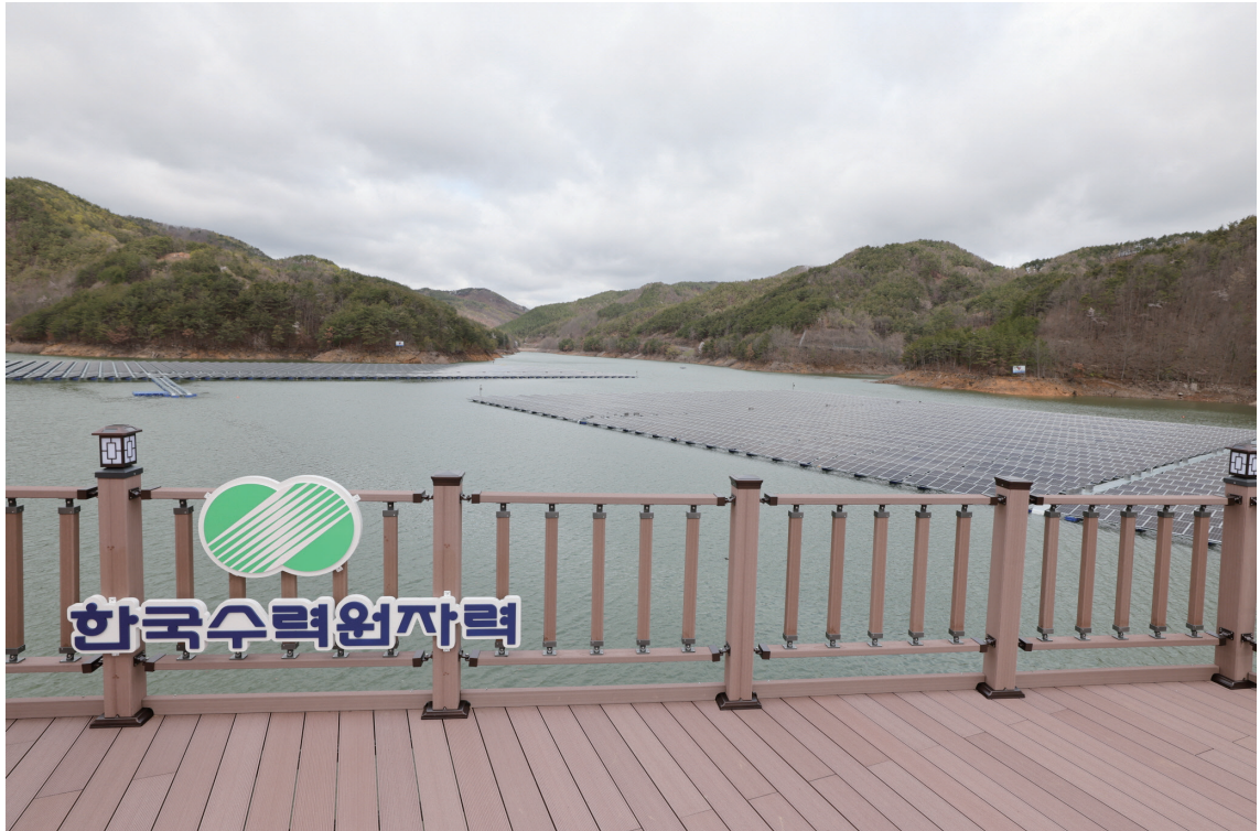
그림 12 청송양수발전소 저수지 수상태양광
