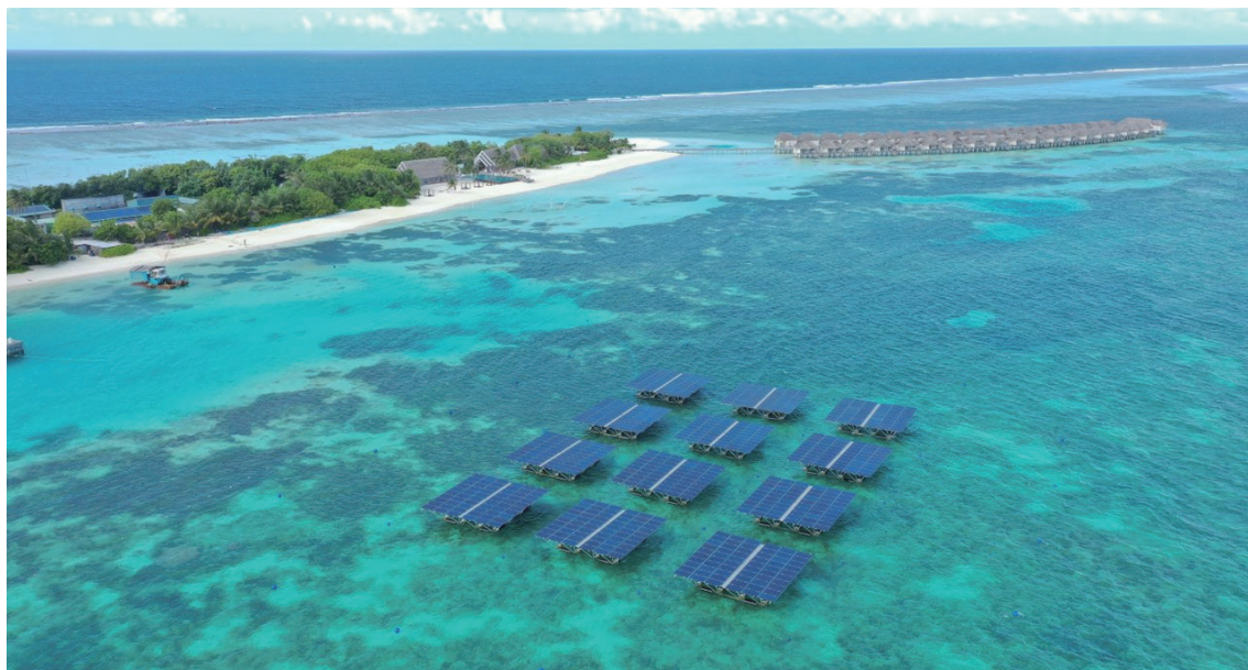
그림 11 해상 태양광 설치사례
