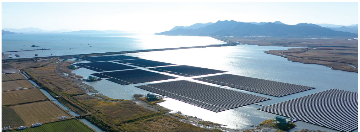
그림 1 전남 고흥의 25MW급 수상태양광 발전소
