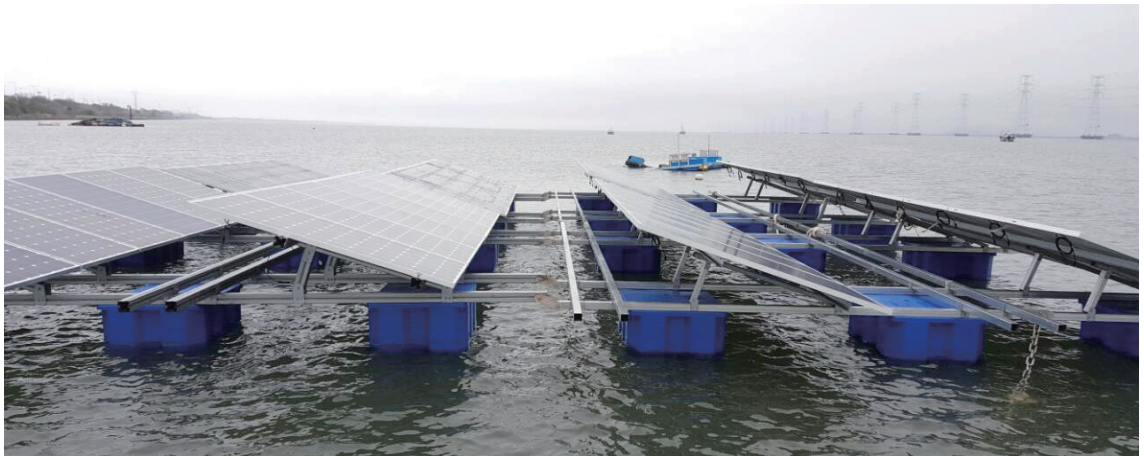
그림 6 금속 지지대가 있는 부유체 예시
