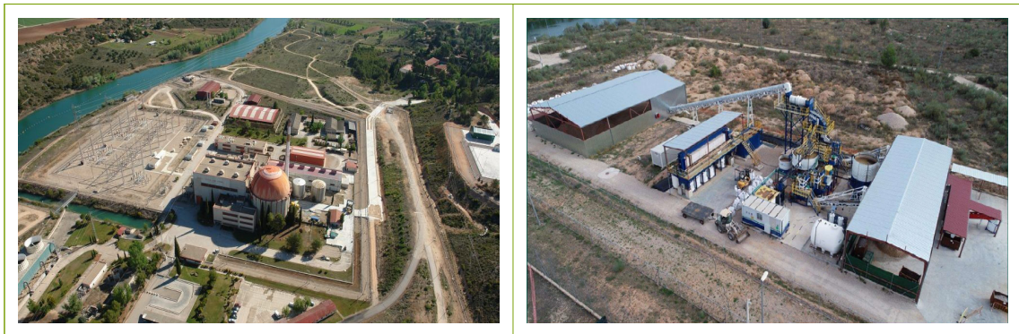
〈스페인 카브레라 원전 전경 및 토양 정화 시설〉
