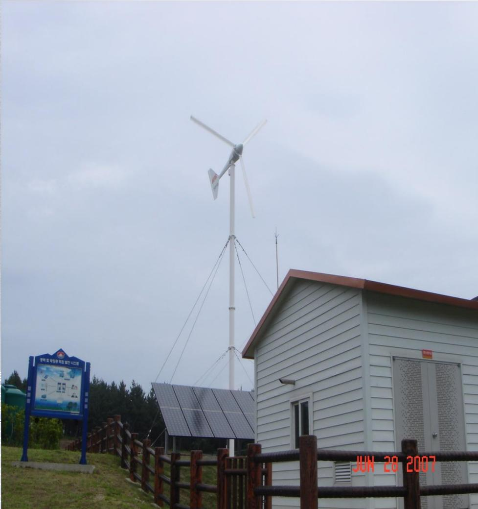
■ 섬의 특성인 바람을 이용하여 태양광발전과 풍력발전을 복합적으로 적용한 사례
