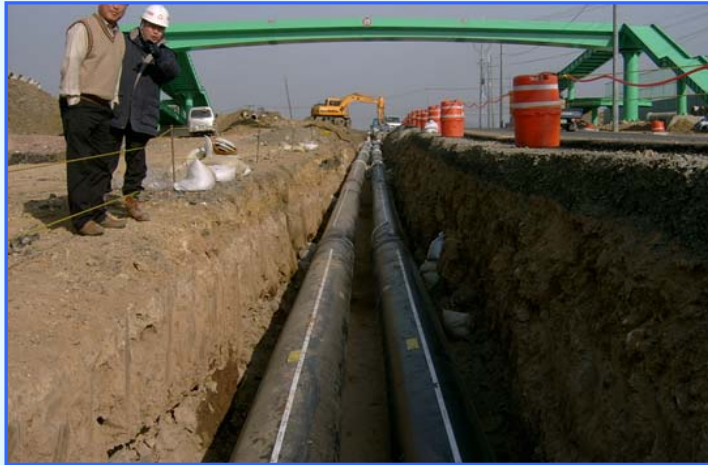
< 열수송관 매설 작업 >
