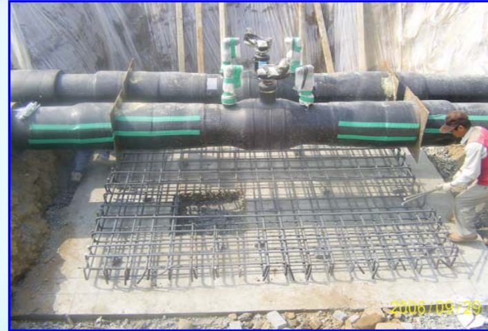
< 열수송관 밸브박스 기초 작업 >
