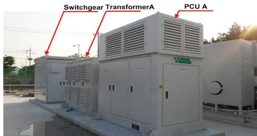
< 2.8MW 연료전지 EBOP : EBOP Layout >
