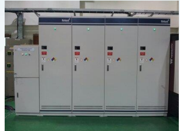
전기연구원 Battery(405kWh) 설치사진
